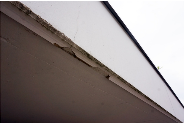
Abbildung 4: Langfristiger Mangel - Abgebrochene Wassernase
